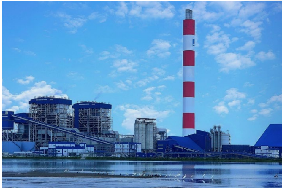
Nhà máy Nhiệt điện Sông Hậu 1 - “điểm sáng” trong xây dựng công nghiệp năng lượng của Petrovietnam giai đoạn vừa qua
