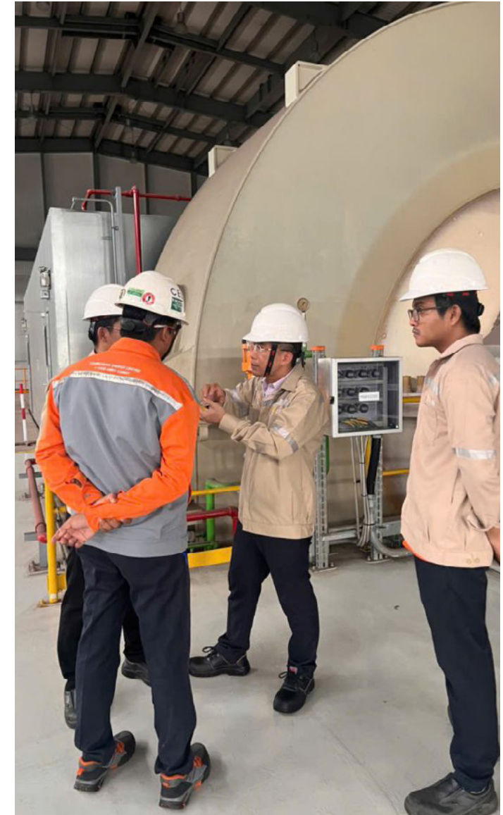
Chuyên gia Hanoi Re đang thảo luận tại hiện trường với đại diện nhà máy CEL trong khu vực tua-bin – một hạng mục trọng yếu trong đánh giá rủi ro kỹ thuật.
